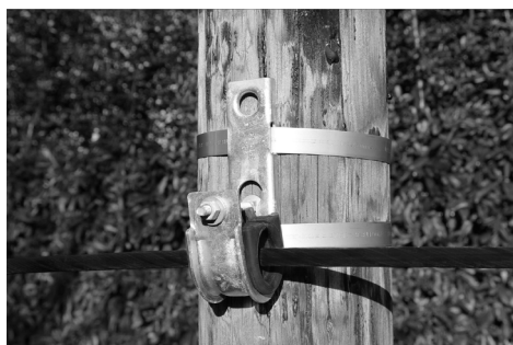
Fixation par 2 bandes de feuillard 20x0,7 ou 0,4 mm
